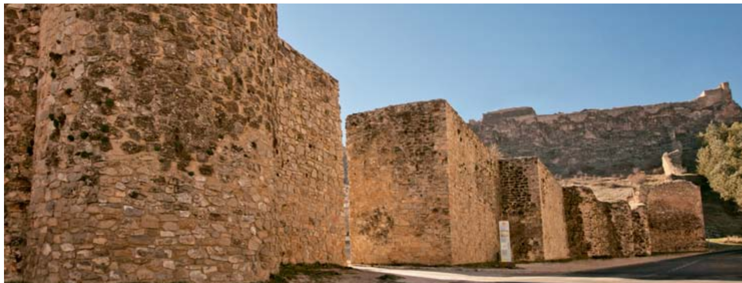
Muralla de Cañete
